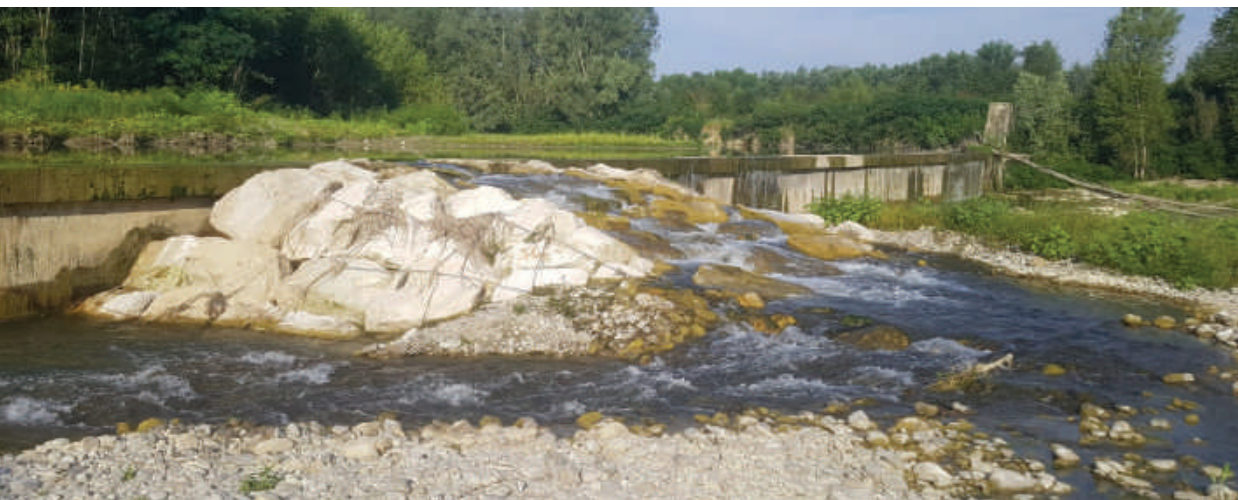
Alcuni dei "passaggi per pesci" costruiti dal LIFE BARBIE sul Fiume Enza Some of the "fish passages" built by LIFE BARBIE on the Enza River
