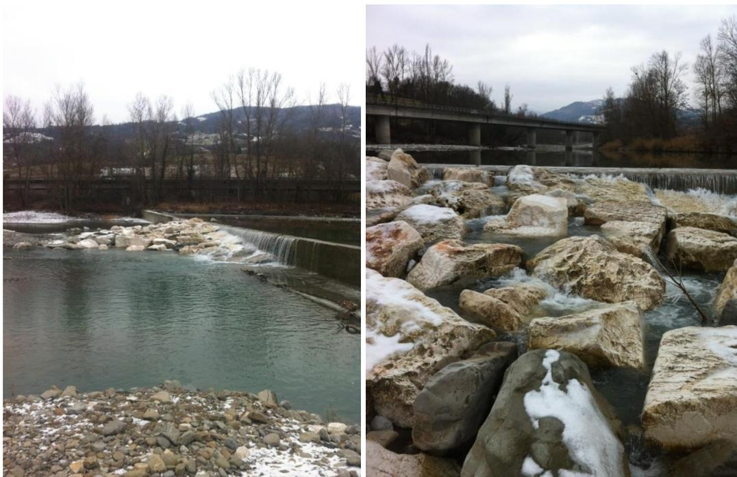
Figura 9: Tipologia rampe in pietrame per passaggio pesci nel fiume Secchia in loc. Debba (RE)
